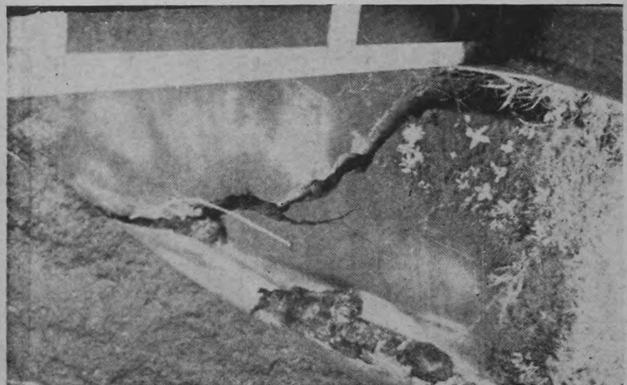
LAVADO POR LA CORRIENTE. — La gráfica presenta el lavado que las corrientadas han producido en el puente de Quebrada Honda, en la carretera Villa Colón-Puriscal. Los temporales han ejercido su manifiesta influencia en todo los ríos del país que, como en este caso, se han desbordado y producido daños de gran magnitud. (Foto Solano).
