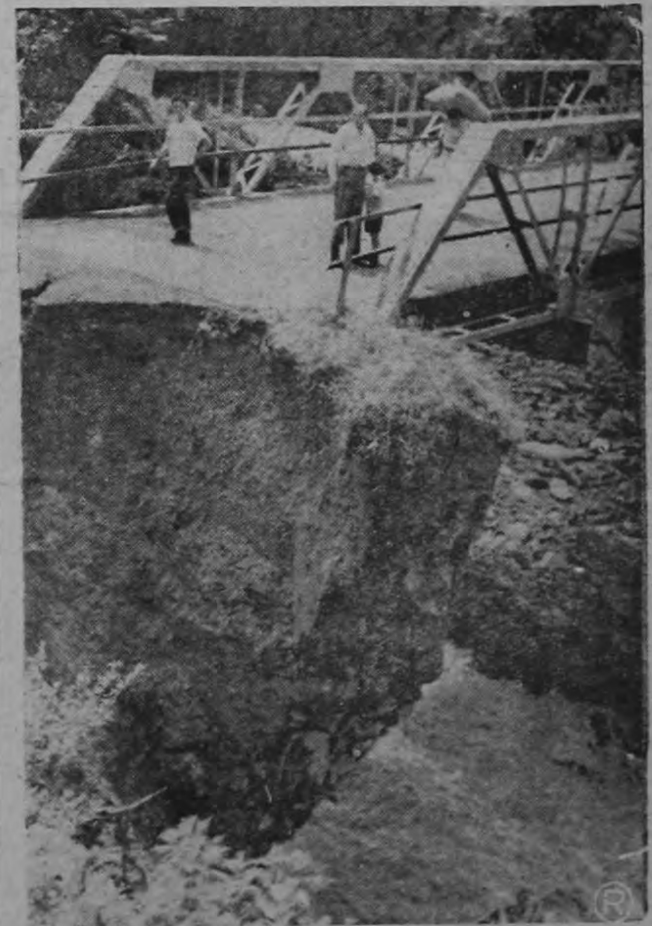
PUENTE SOCAVADO EN SUS BASES. — El puente de Quebrada Honda, en la Carretera Villa Colón-Puriscal, completamente socavado por las grandes corrientes motivadas por el temporal. Obras Públicas, visto el peligro que representa el estado de ese puente, ha dispuesto lo necesario para que se efectúen las reparaciones. (Foto Solano).
