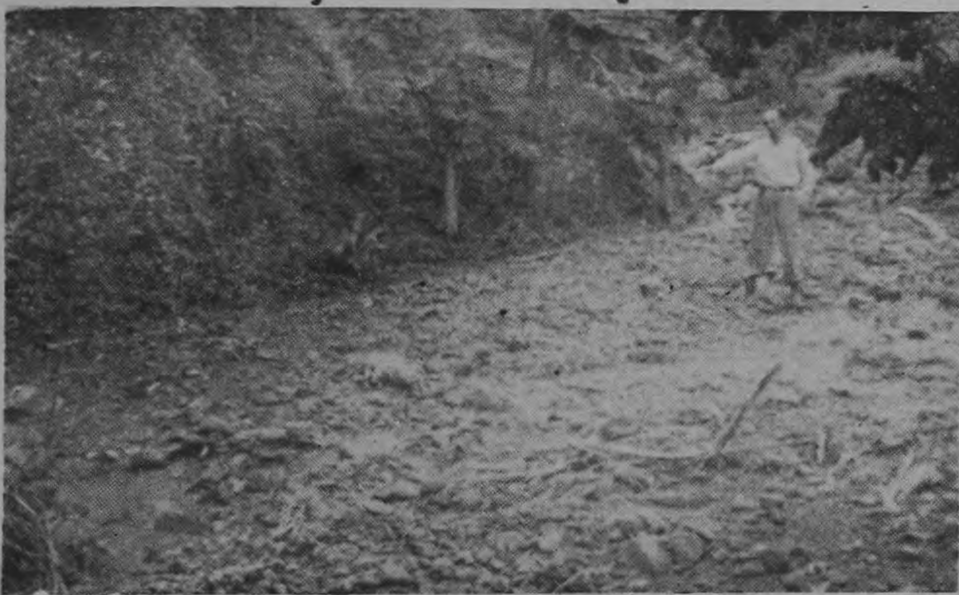
El Puente de Quebrada Honda, sito en la carretera Villa Colón-Puriscal, ha estado a punto de derrumbarse como consecuencia de las crecidas que los ríos han experimentado con el temporal que azotó a la república durante los días últimos. La gráfica presenta al diputado don Rafael Solórzano, señalando el sitio en donde antes estuvo una casa que fue completamente barrida por la correntada.
